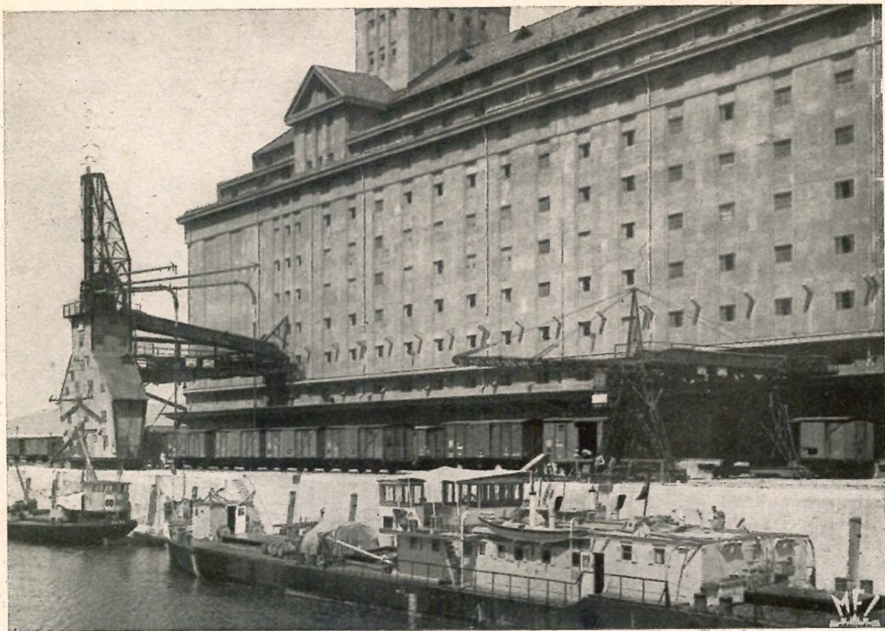
Hat-hét emelet magas és húsz-harminc méter hosszú modern «vas-állatok» (elevátorok és daruk) végzik a rakodás nehéz munkáját a csepeli szabadkikötőben.
