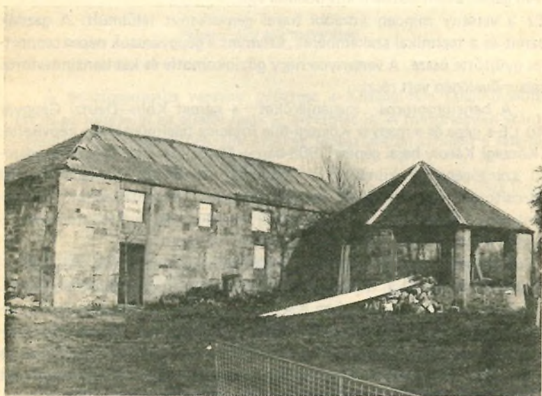
Szárazmalom épülete Skóciában, 1984-ben átalakítás közben
